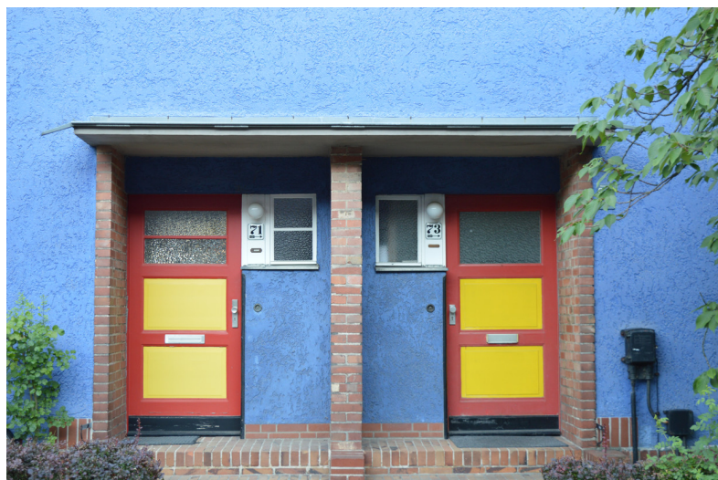
Huizen uit de Hufeisensiedlung in Berlijn, ontworpen door Taut. Beeld Nadia Abdelkaui
